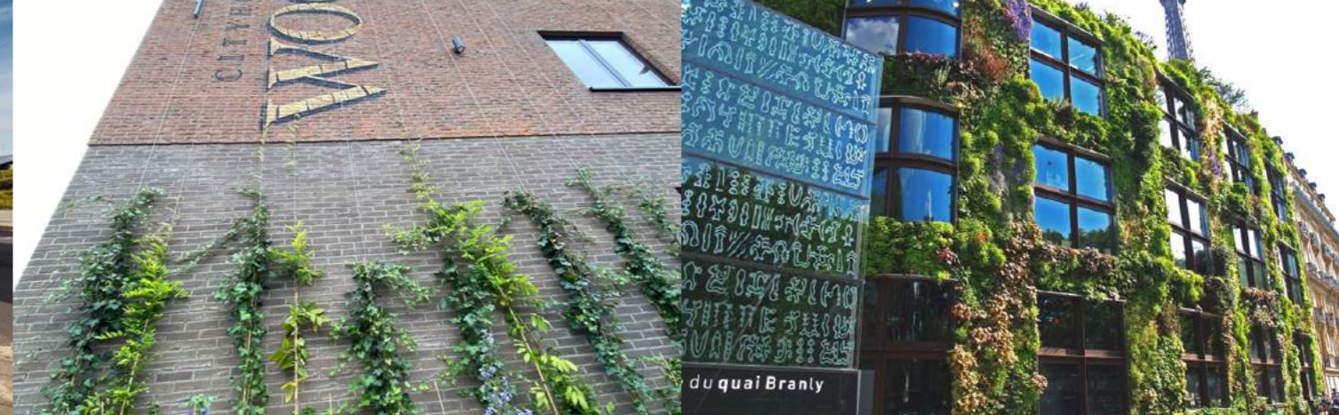
Afbeelding: De groene gevel van Cityhotel Wood in Middelburg (bron: https://cityhotelwood.zeayouzeeland.nl/nl/informatie/duurzaamheid )
