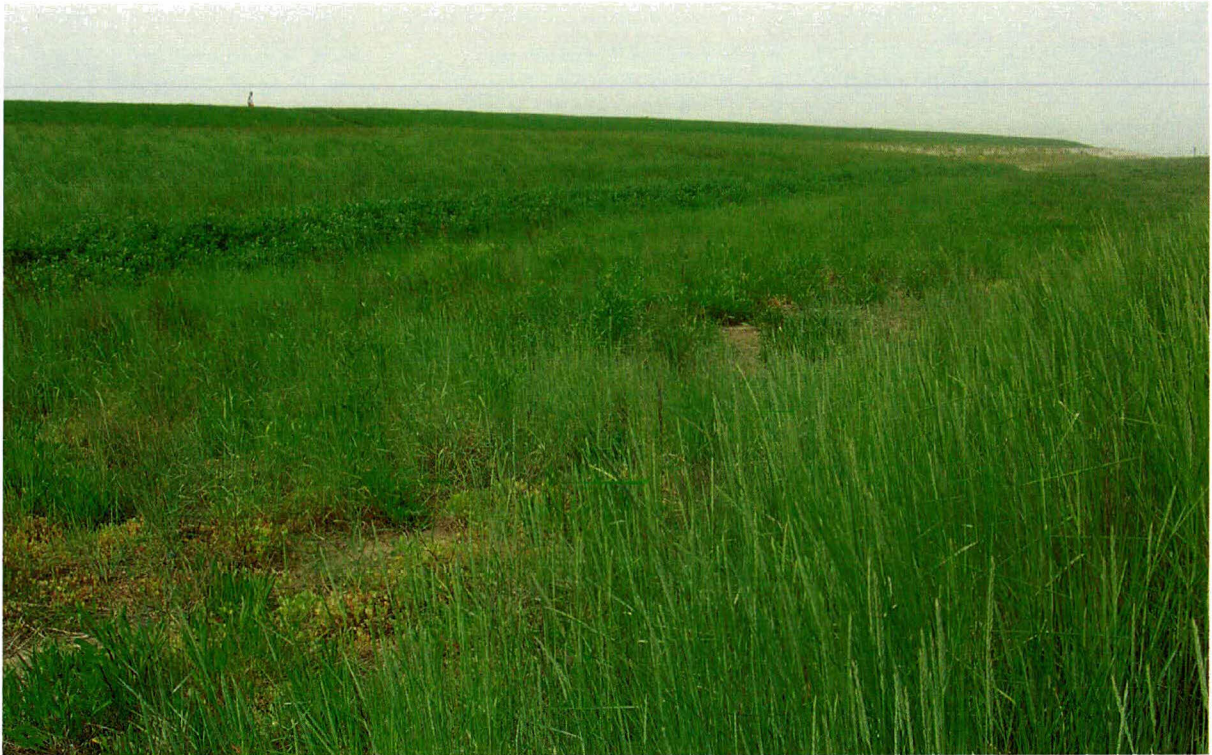
Foto 8 Proefstrook 3: Hellegatpolder; grens werkstrook te herkennen in vegetatie, de hoge vegetatie rechtsonder is niet verstoord geweest, de lagere strook parallel aan de dijk wel.
