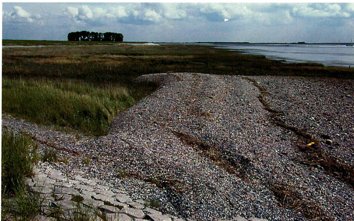
Foto 31 Proefstrook 24, Zimmermanpolder: steenslag waarmee de dijk is afgestrooid spoelt van de dijk en verzamelt zich hier op het schor als een soort van strandhaak.
