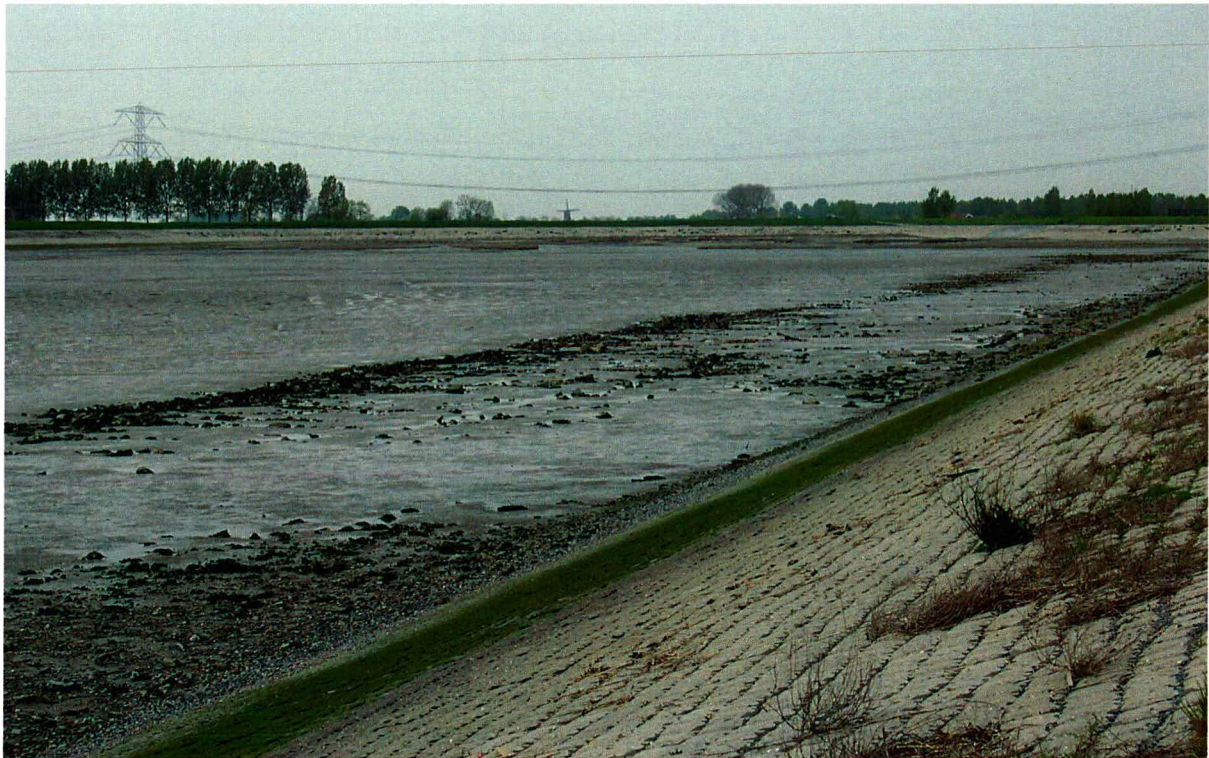
Foto 26 Proefstrook 16, Biezelingse Ham: een duidelijke band met stenen op het slik 25 meter uit de dijkvoet; waarschijnlijk heeft hier de uitgegraven grond gelegen waarin stenen van de kreukelberm hebben gezeten. Een deel van de stenen is na het terugzetten van de grond achtergebleven.
