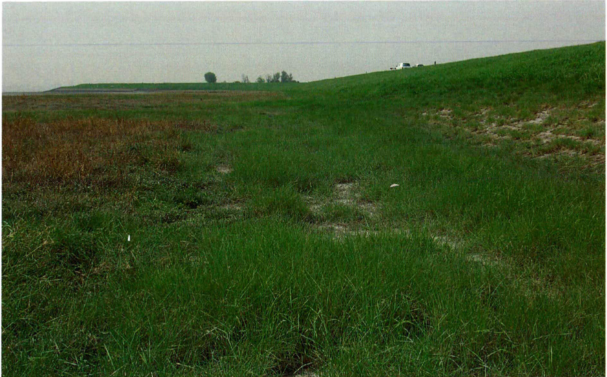
Foto 16 Proefstrook 8: Baarlandpolder; door hogere afwerking van werkstrook ontstaat een afwijkende vegetatie parallel aan de dijk, in dit geval gedomineerd door Strandkweek.
