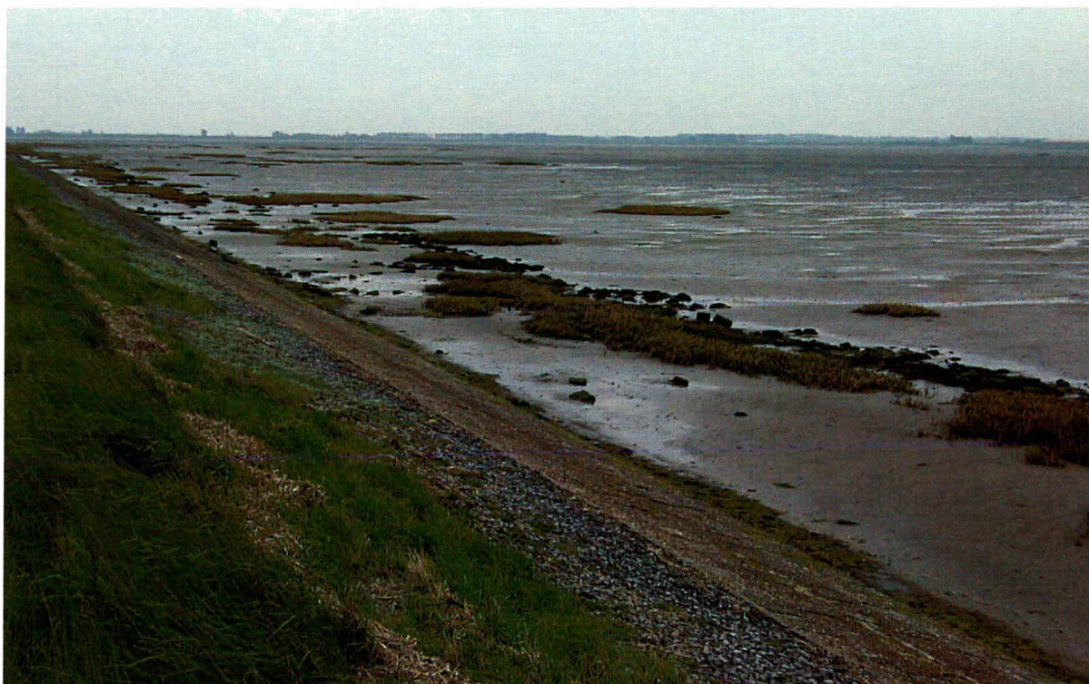
Foto 39 Proefstrook 31, Philipsland: op 8 meter uit de teen van de dijk een duidelijke strook met stenen.
