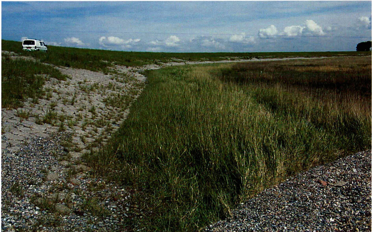
Foto 32 Proefstrook 24, Zimmermanpolder: duidelijke band van afwijkende vegetatie langs de dijk, dit is een gevolg van het hoger afwerken van de werkstrook; deze ligt zeker meer dan 15 cm hoger dan het originele schor.
