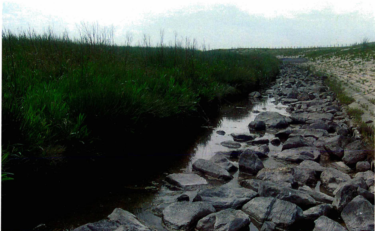
Foto 27 Proefstrook 19, Waarde-west: keurig smalle werkstrook van 2 meter waardoor een geul in het schor is gespaard: de werkstrook is niet weer afgedekt met de uitgegraven grond, onbekend is waar deze (verontreinigde) grond gebleven is.
