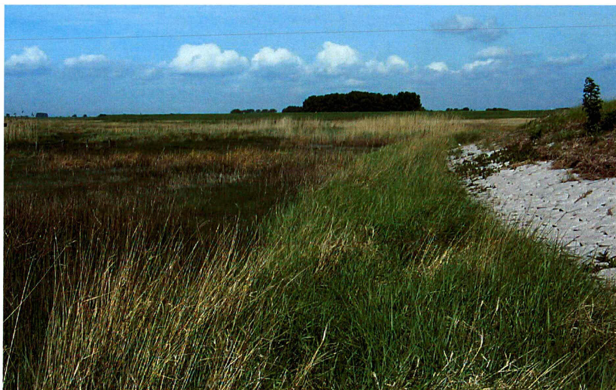
Foto 30 Proefstrook 22, Zimmermanpolder: geen zichtbare werkstrook, de strook strandkweek groeit al op de aanzet van de dijk.
