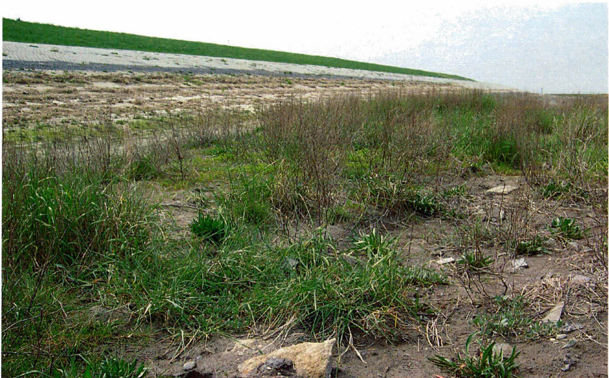
Foto 9 Proefstrook 4: Hellegatpolder: stenen aan de oppervlak in werkstrook. Werkstrook hobbelig afgewerkt.
