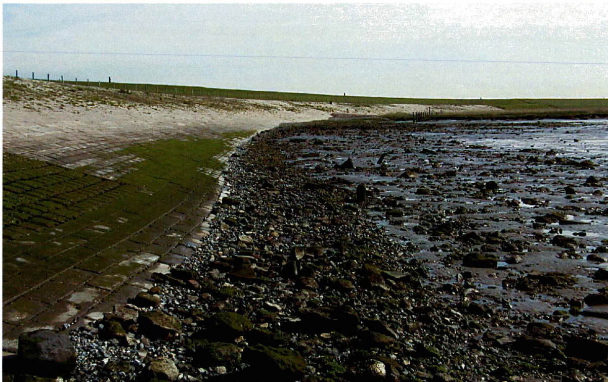
Foto 28 Proefstrook 20, Waarde –west: vrij veel stenen verspreid over het slik tot 8 meter breed.
