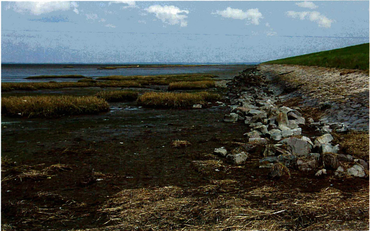
Foto 36 Proefstrook 27, Rattekaai: slik met een keurige smalle strakke kreukelberm en zonder stenen op het slik.
