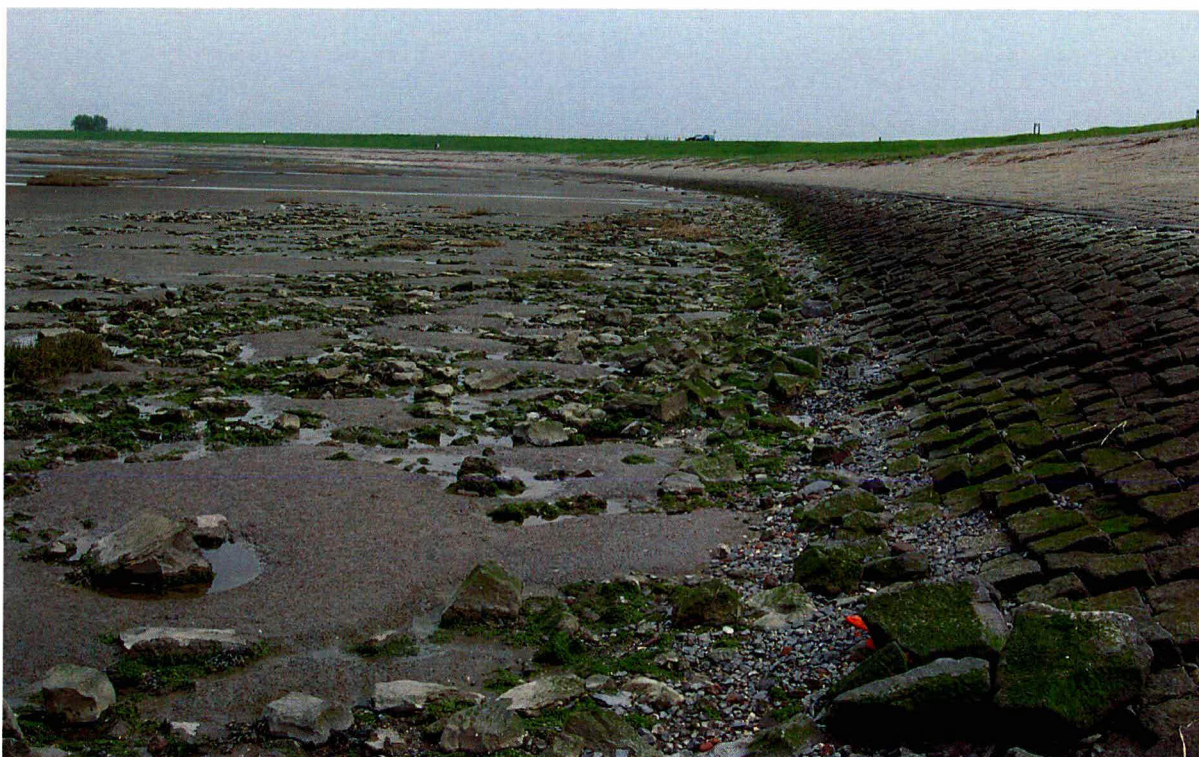
Foto 11 Proefstrook 5: Baalhoek; breed uitgewaaierde (15 meter) kreukelberm op het slik.
