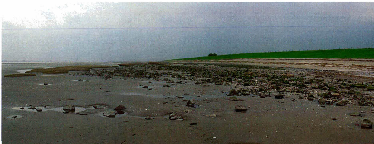
Foto 12 Proefstrook 6: Baalhoek: grote hoeveelheden stenen op voormalig primair schor tot wel 20 meter uit de dijkvoet.
