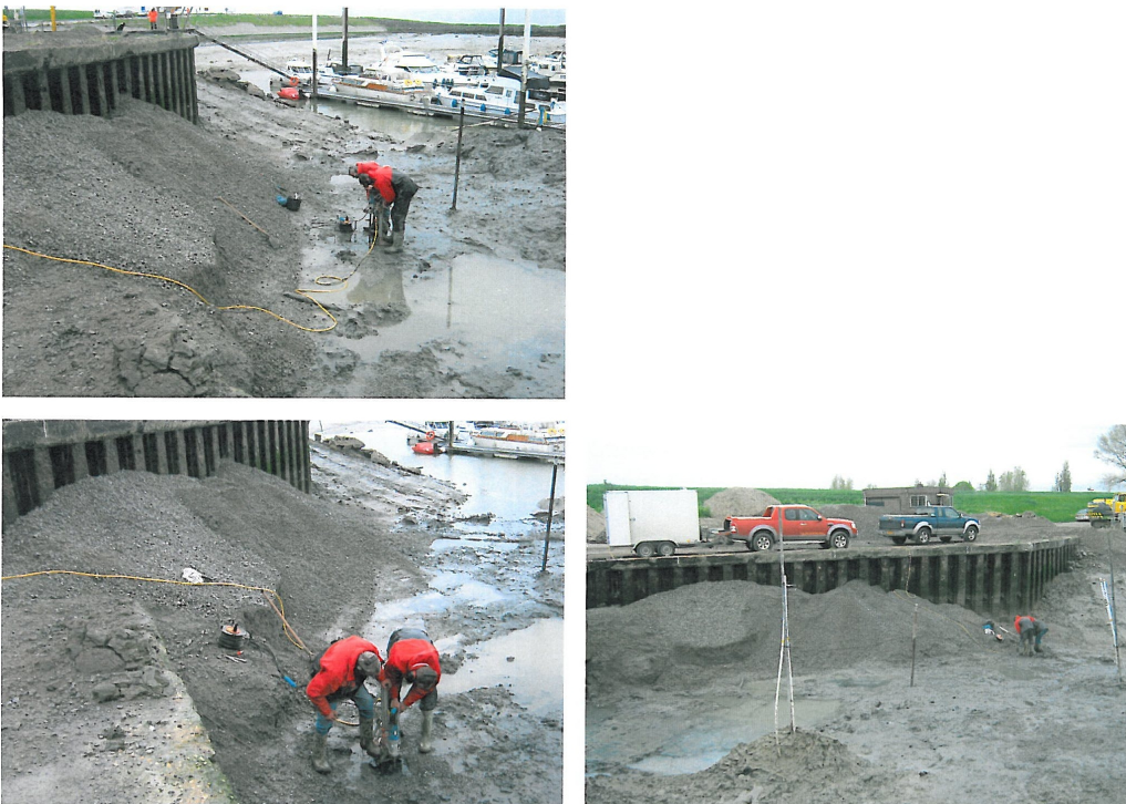
Figuur 2.5: Het zetten van kernboringen in de laag versterkt sediment
