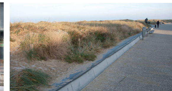
Betonnen band wordt omhoog getild bij entrees
