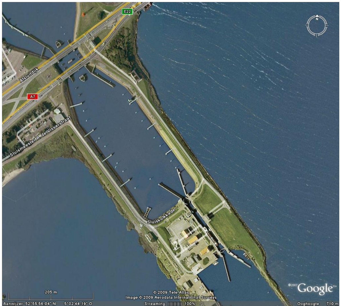
Figuur 3.1 Overzichtsfoto Stevinssluuis met zijn voorhavens naar Waddenzee (Noord) en IJsselmeer (Zuid). Bij de letter S van de tekst Sluiskolkade in de foto is de uitlaat van het gemaal Leemans zichtbaar.
