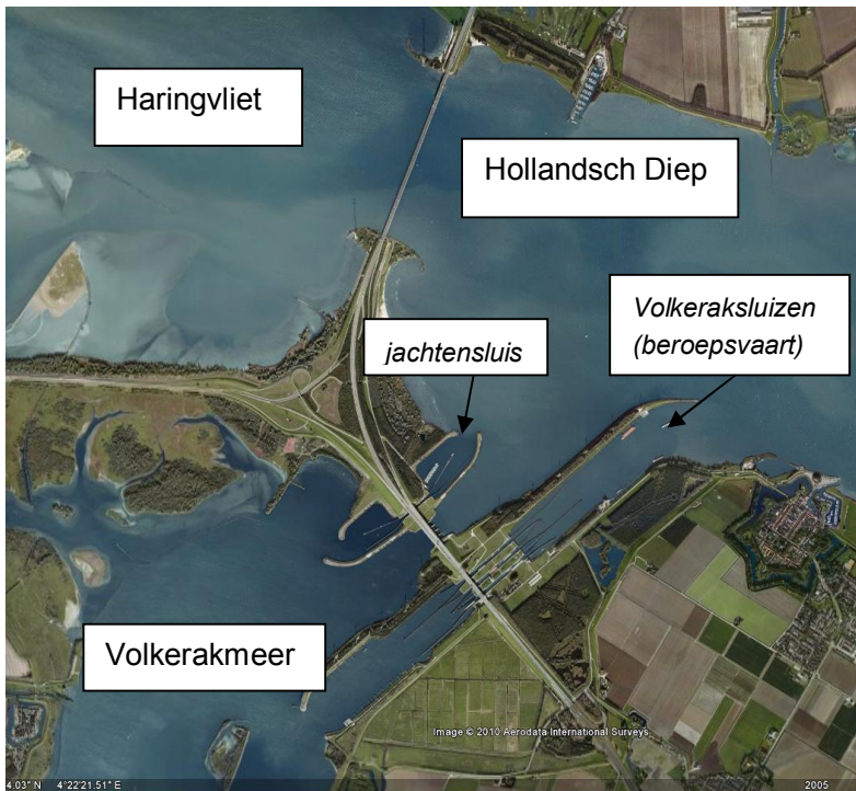
Figuur 1.1 De Volkeraksluizen vormen de verbinding tussen het Volkerak en het Hollandsch Diep. De scheepvaartsluizen bestaan uit 3 beroepsvaartsluizen en 1 jachtensluis. Tussen beide sluizencomplexen bevindt zich een spuisluis (Bron: Google Earth)
