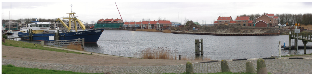
Figuur 9-1: buitendijkse bebouwing op havendam Tholen
