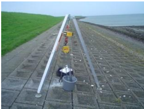
Figuur E.1 Voorbeeld van de trekproef met driepoot. De driepoot is correct geplaatst: geen poot staat op een blok wat direct grenst aan het blok waaraan wordt getrokken. Maar de overmaat aan ketting van het hijsblok vormt extra excentrisch gewicht op de steen waar aan wordt getrokken: zo moet het niet
