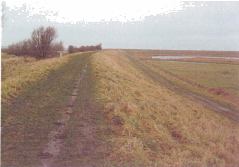
Foto 2.3 De kruin van de dijk tussen dp1900 en dp1905 wordt intensief gebruikt door recreanten (gezien in noord-oostelijke richting). Een berm aan de buitenzijde (links) ontbreekt vanwege het naastgelegen duinterrein. In de toekomstige situatie is de kruin verhard met een onderhoudspad van asfaltbeton.
