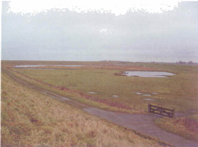
Foto 1.1 Inlaag Thoornpolder (in oostelijke richting gezien)
