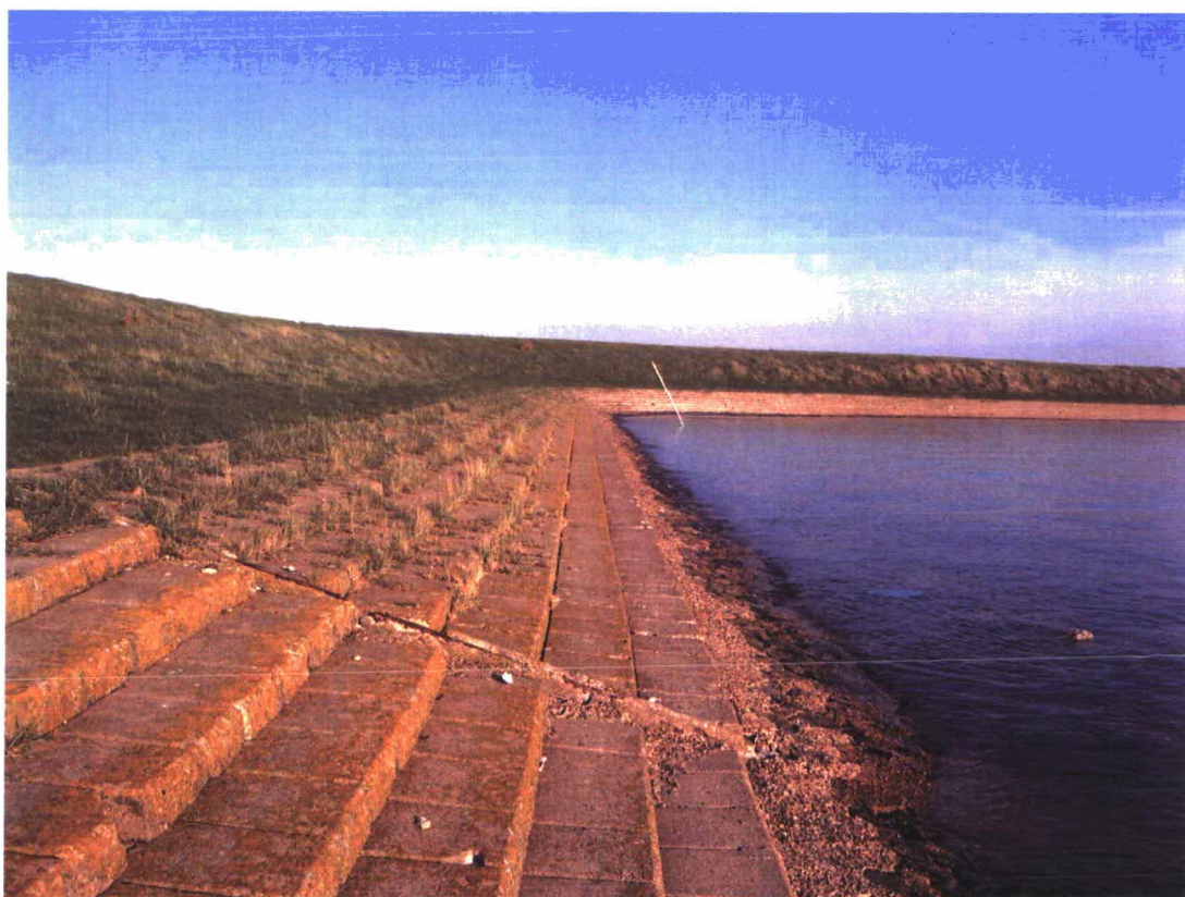
Foto 1.2 Huidige dijkbekleding in deelgebied 5.
