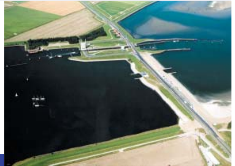
De Zandkreekdijk met in het midden de Katse Heule. Het doorlaatmiddel is gebouwd op de plek waar de dam in 1960 werd gesloten.
