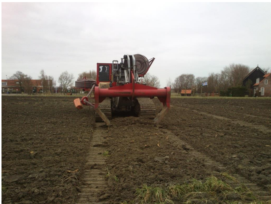
Figuur 2.6 Aanleg van de peilgestuurde drainage.
