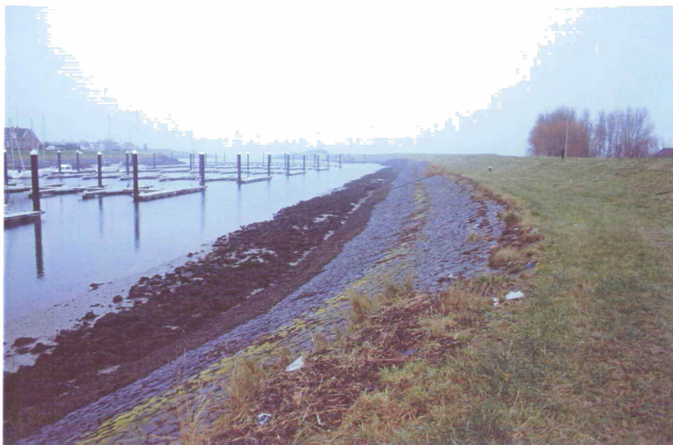
Figuur 7 De glooiing van de dijk in de haven van Wemeldinge (deelgebied 3)
