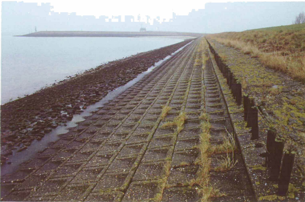
Figuur 5 Glooiing van de dijk ter hoogte van deelgebied 1
