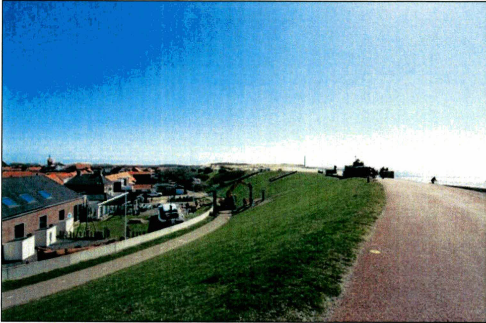
Figuur 9.1. Werkgebied A ter hoogte van dijkspaal 210.
