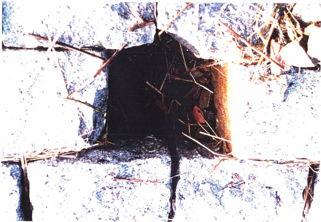
Foto 2 Gat in de bekleding in vak 1. Ook hier is het filter open.
