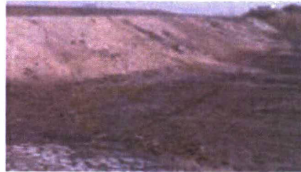
Zand gestort tegen dijkgedeelte langs Ritthemsestraat
