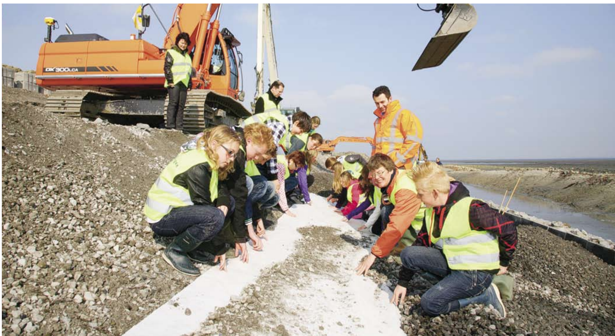
Onder toezicht van de projectleider bekijken de basisschoolleerlingen de materialen op de dijk. Ze mogen even voelen aan het filterdoek en de kleine steentjes.
