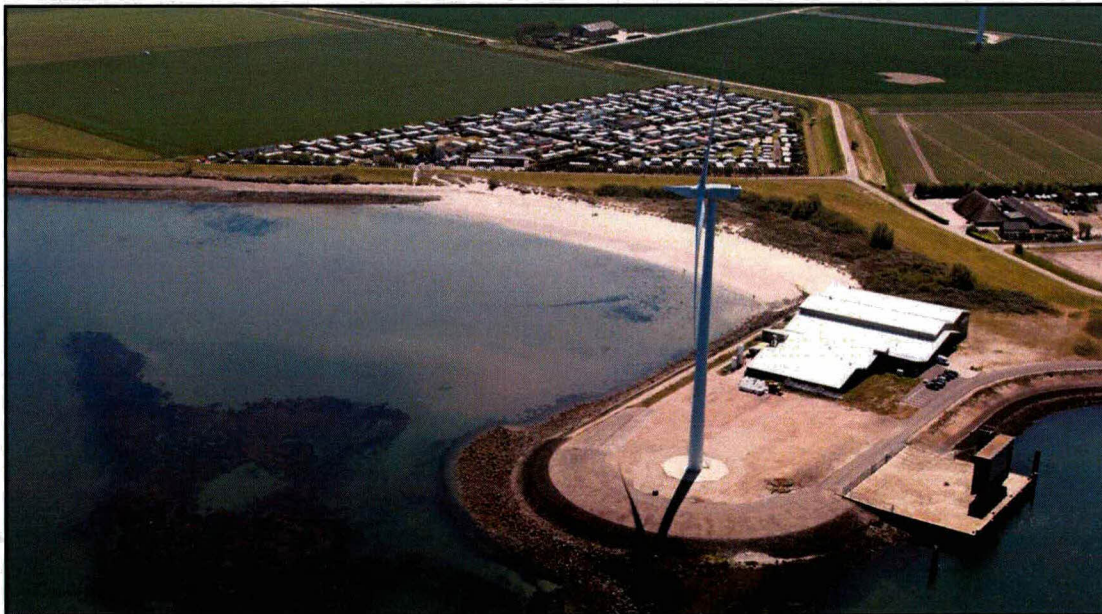
Afbeelding 4: Huidige situatie van de dijk tussen dp1934 en dp1942, waarbij het onderhoudspad niet is opengesteld. Ook goed zichtbaar is het strand met daarachter duin.
