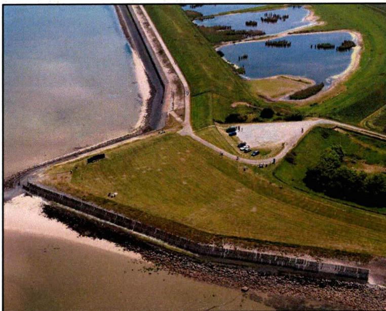
Afbeelding 17: Huidige situatie met de parkeerplaats aan de westzijde van de Anna Friso Inlaag
