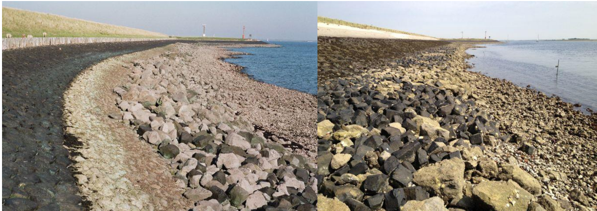
Figuur 4. Vergelijking dijkvak 15: Bruinissepolder 2005 (links) met 2012 (rechts)
