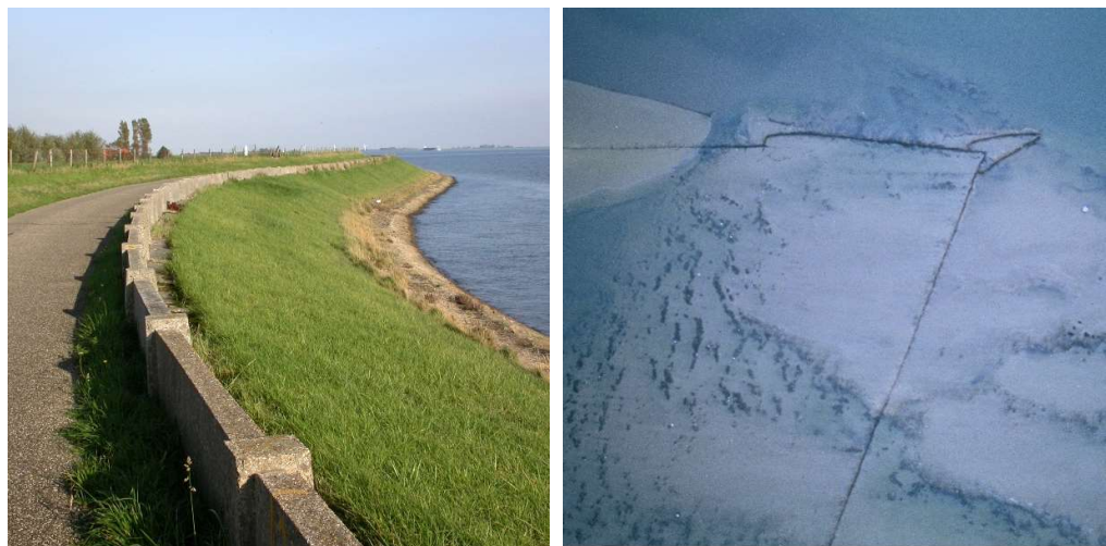
Figuur 25. Links een muraltmuurt bij de Oosterlandpolder (RWS Beeldbank, Jan van den Broeke), rechts de praktijk van weervisserij waar op een plaat een trechter met aan het eind een fuik is geplaatst (RWS Beeldbank)
