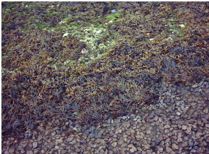
Figuur 4.2 Begroeiing van open steenasfalt in de getijzone
