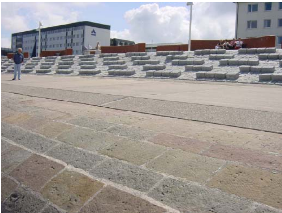
Figuur 4.3: Ribbels als ruwheidselementen op talusbekleding Norderney (Noord Duitsland)
