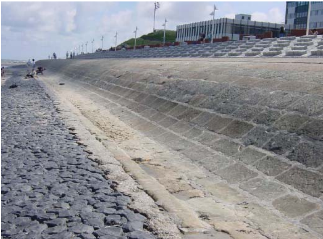
Figuur 4.2: Overzicht talusbekleding Norderney (Noord Duitsland)
