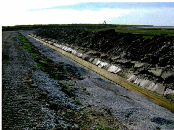
Figuur 1: Ontgraven dijkteen en werkstrook met zand op schor 't Stelletje.
