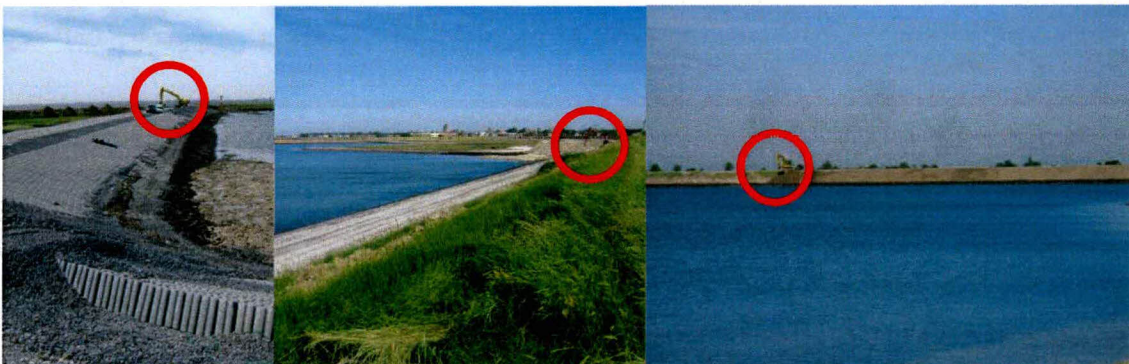
Figuur 2: Werkzaamheden vinden langs verschillende delen van de dijk plaats. Van links naar rechts: langs Haven de Val, langs de Gouweveerpolder en langs de polder Zuidhoek.
