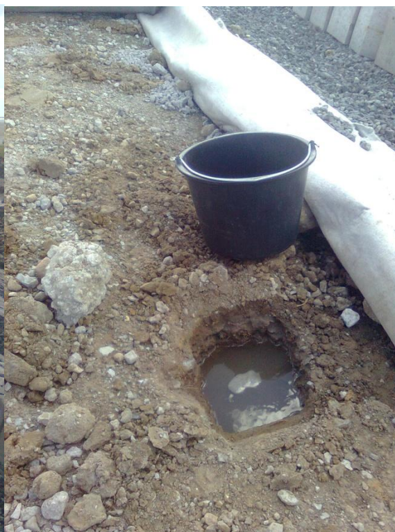
Foto 2: Infiltratiekuil voor indicatieve beoordeling doorlatendheid (Stavenisse)
