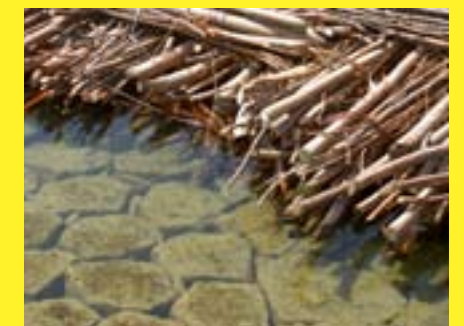
De wilgenmatten worden gemaakt met bundels van rishout: tenen en twijgen van wilgenhout.
