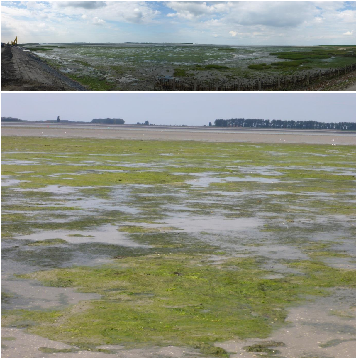
Figuur 6. Boven: overzicht van Zandkreek met links dijkwerkzaamheden. Onder: zeegrasoases (donkergroen) tussen wierwoekering (lichtgroen)
