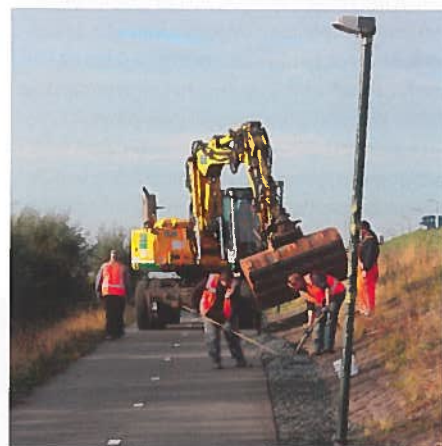
Het aanbrengen van polyurethaangebonden bekleding.
