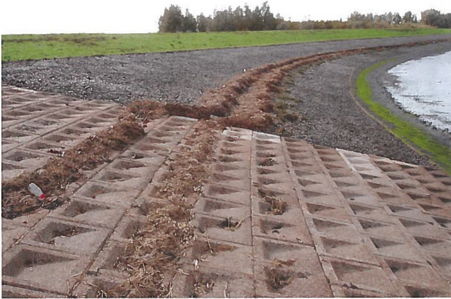
Pba biedt een interessant civieltechnisch en ecologisch perspectief en heeft een vaste plaats gevonden tussen meer conventionele dijkbekledingsmethoden.
