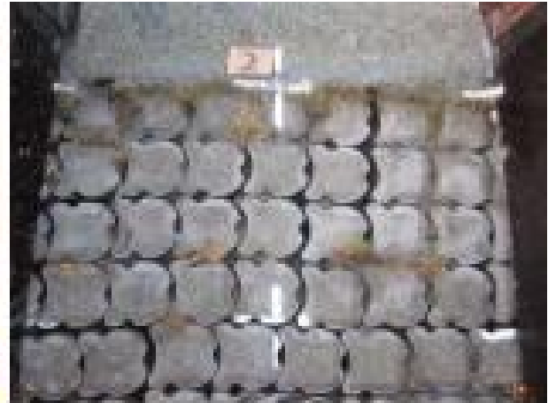
Figuur T1-2: proef 1-0 na 19:31 uur, overgang Hydro Blocks naar asfalt, de naden tussen de betonblokken schoongespoeld
