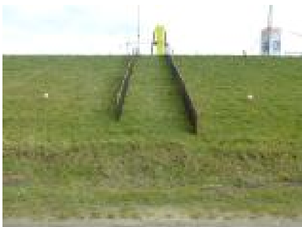
Figuur T2-3: Nulsituatie, overzicht foto teststrook 2 binnentalud
