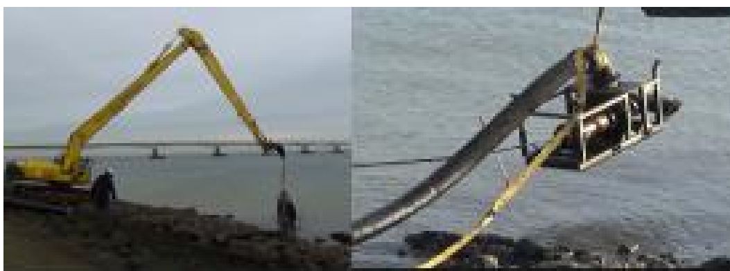
Figuur 2-2: Plaatsen van de pomp
