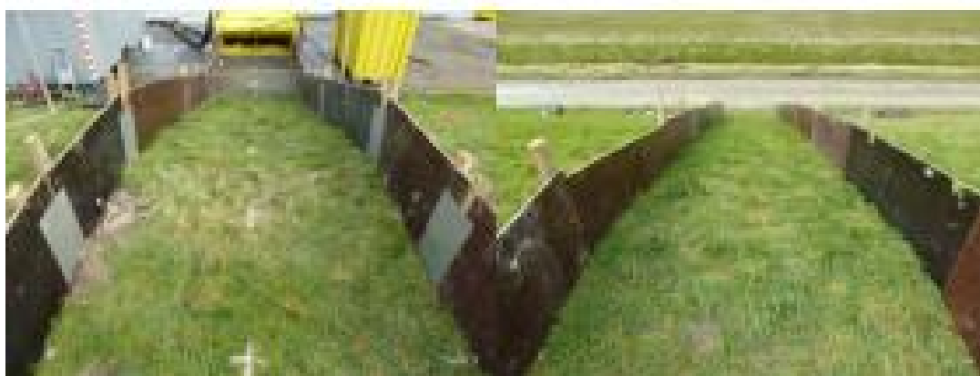
Figuur 5-6: Teststrook 2, met links het buitentalud en rechts het binnentalud
