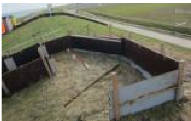
Figuur 2-3: De opvangconstructie op de kruin
