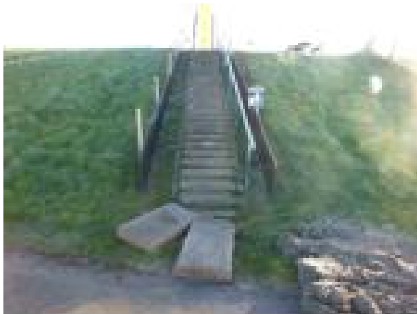
Figuur 5-17: Over de kruin geslagen treden
