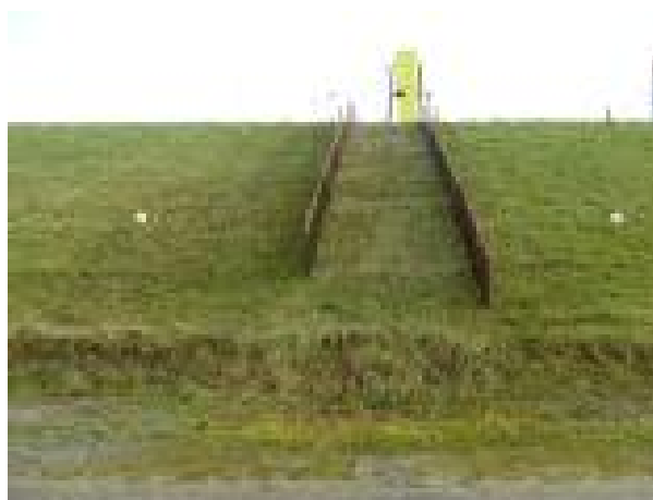
Figuur T2-4: proef 1-0 afgerond, overzicht foto teststrook 2 binnentalud
