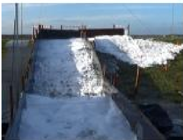
Figuur 5-3: De geleideschotten op de kruin die het water terugleidt naar de Oosterschelde
