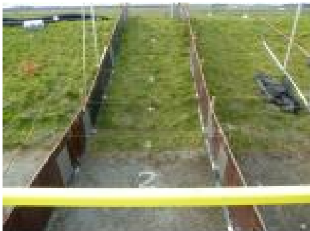
Figuur T2-1: Nulsituatie, overzicht foto teststrook 2 buitentalud
