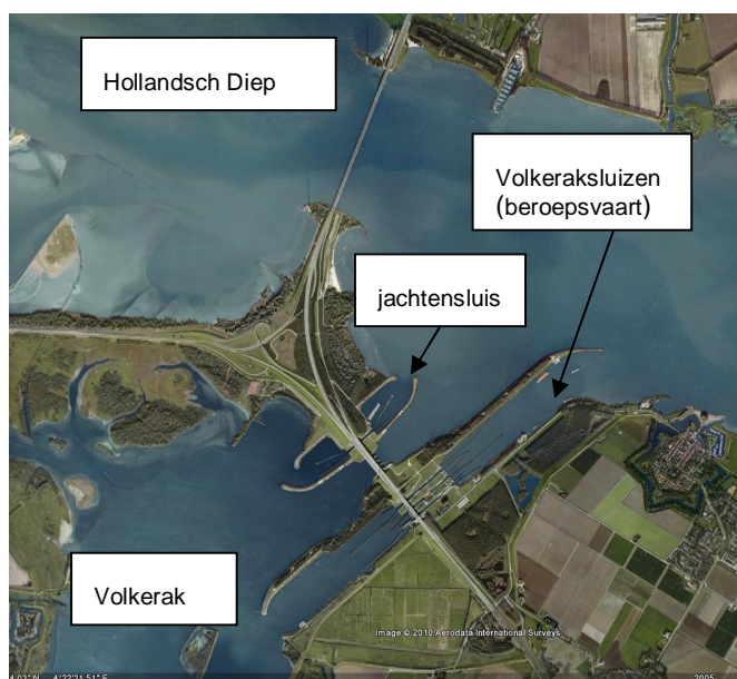
Figuur 1.1 De Volkeraksluizen vormen de verbinding tussen het Volkerak en het Hollandsch Diep. De scheepvaartsluizen bestaan uit 3 beroepsvaartsluizen en 1 jachtensluis. (Bron: Google Earth)
