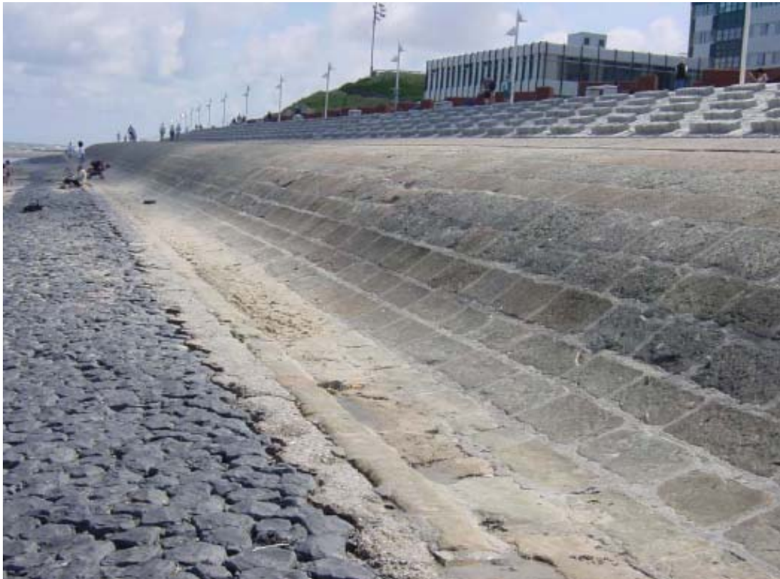
Figuur 5.1: Overzicht taludbekleding Norderney (Noord Duitsland)
