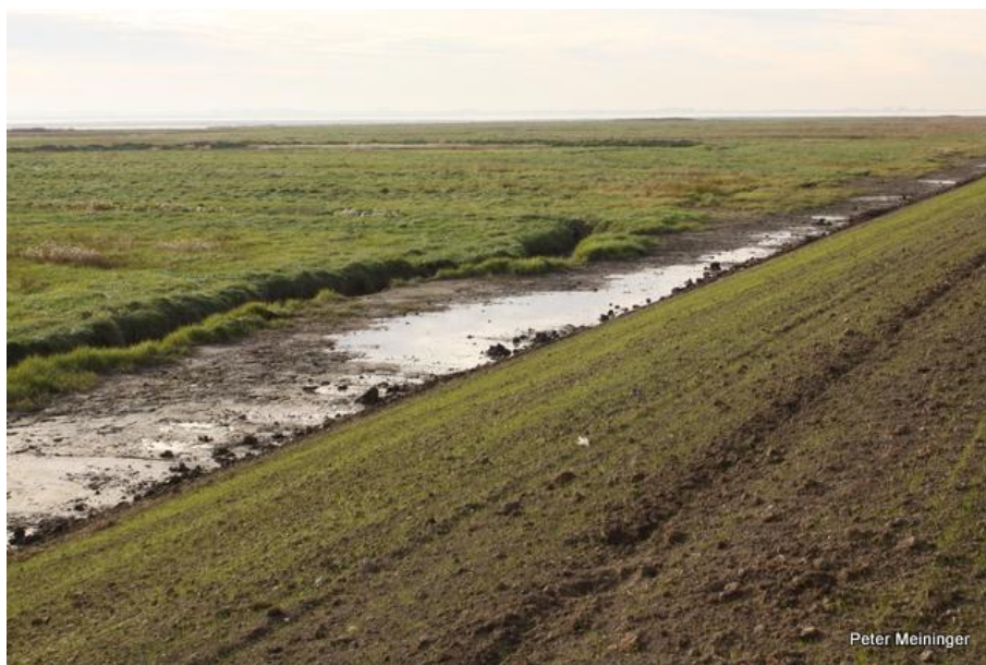
Dijktraject Schor Emanuelpolder. Te ontwateren plas in werkstrook.
