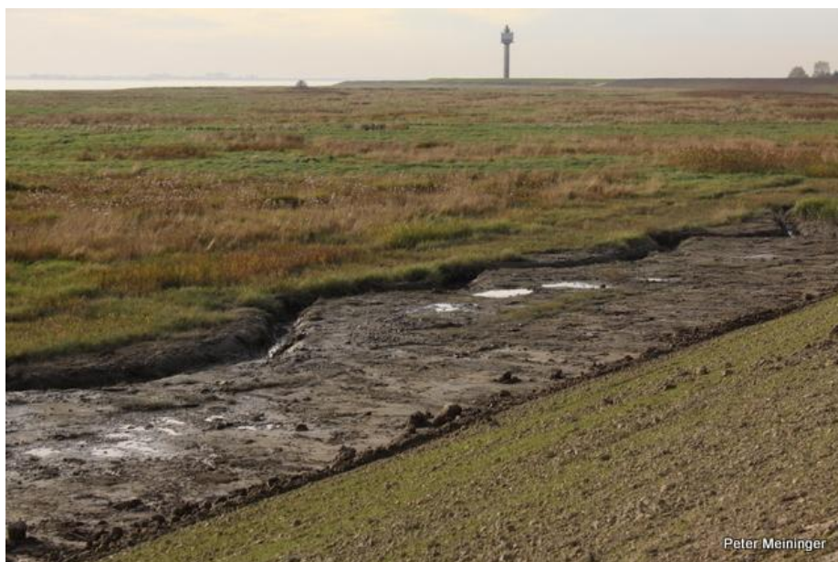
Dijktraject Schor Emanuelpolder. Herstelde krekens in werkstrook.
