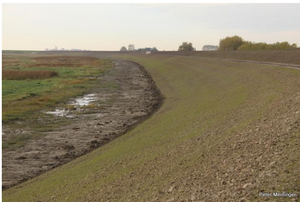
Dijktraject Schor Emanuelpolder. Afgewerkte werkstrook.
