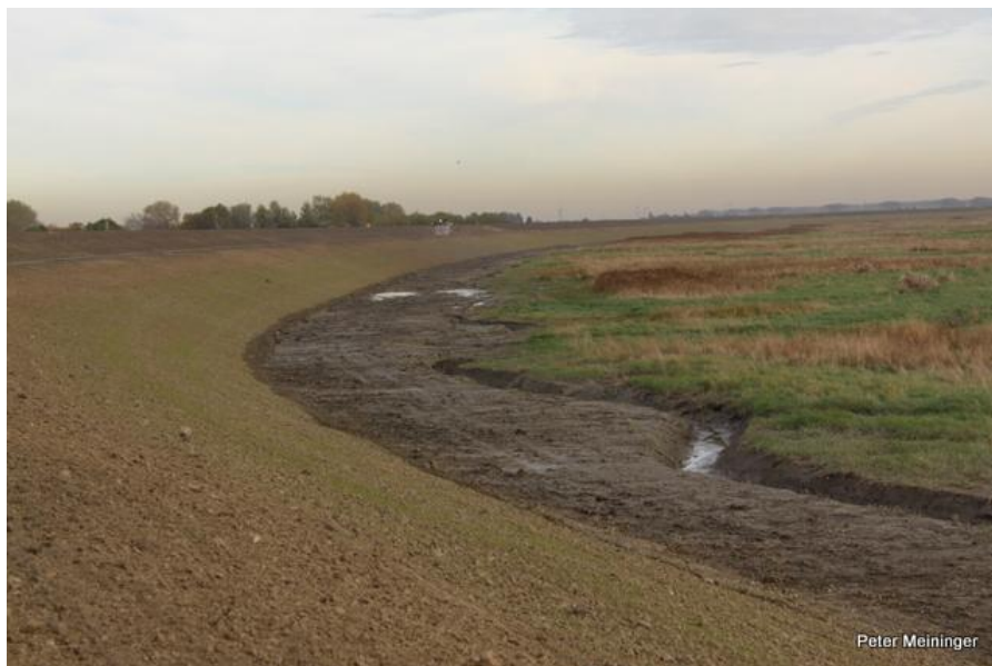
Dijktraject Schor Emanuelpolder. Herstelde krekken in werkstrook.
