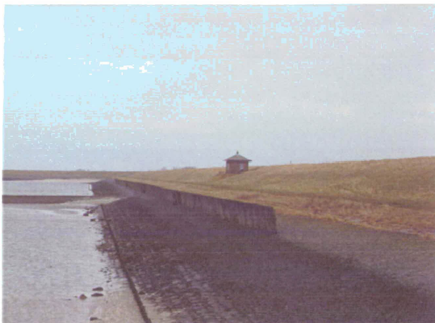
Foto 2.1 Bestaande palenrij tussen dp1833+50m en dp1891 welke gehandhaafd blijft in de toekomstige situatie
