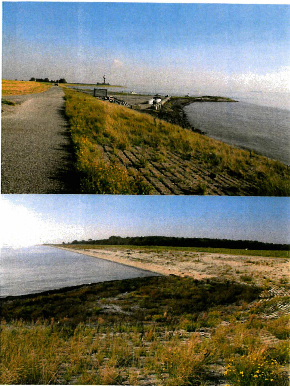
Figuur 1.3 Buitendijkse haven van Waarde en stenige hoekje ter hoogte van dp 184 - 187 (gelegen buiten projectgebied)
