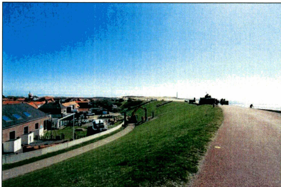
Figuur 9.1. Werkgebied A ter hoogte van dijkspaal 210.
