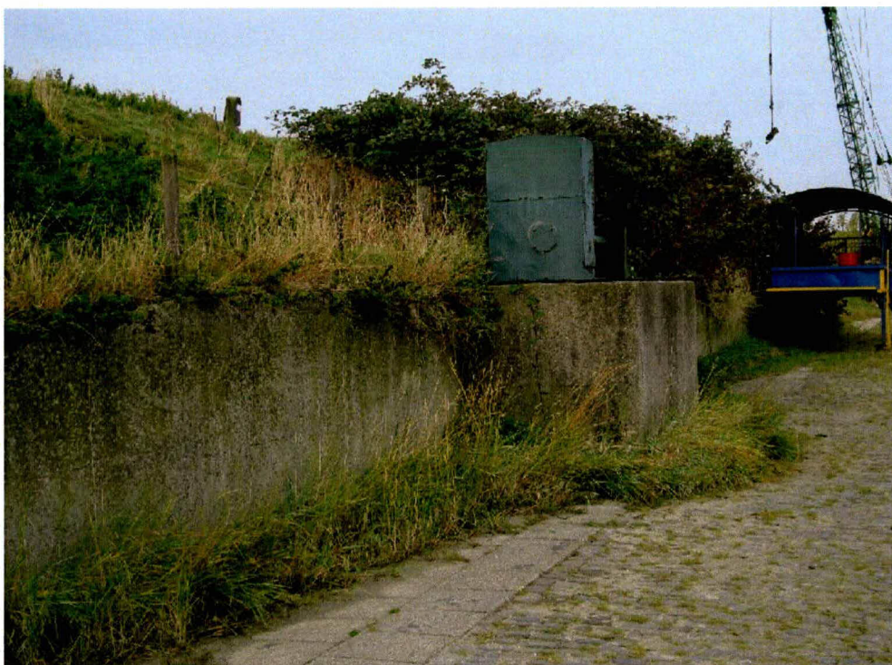
Figuur 1: Sluisje op betonnen scherm
