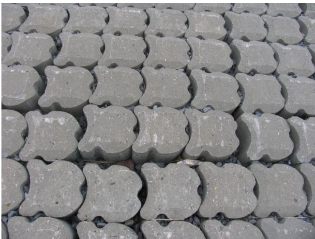
Figuur 1.1 Steenzetting met plaatselijk relatief veel ruimte tussen de stenen
