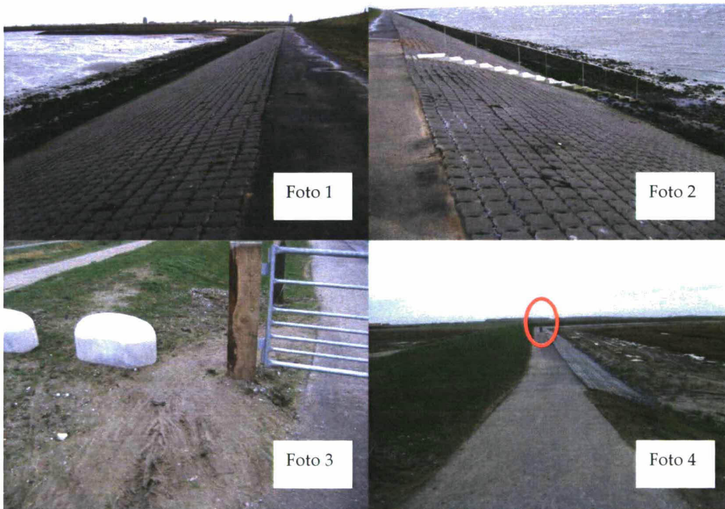
Foto 1: Verhard onderhoudspad langs de Gouweveerpolder.
