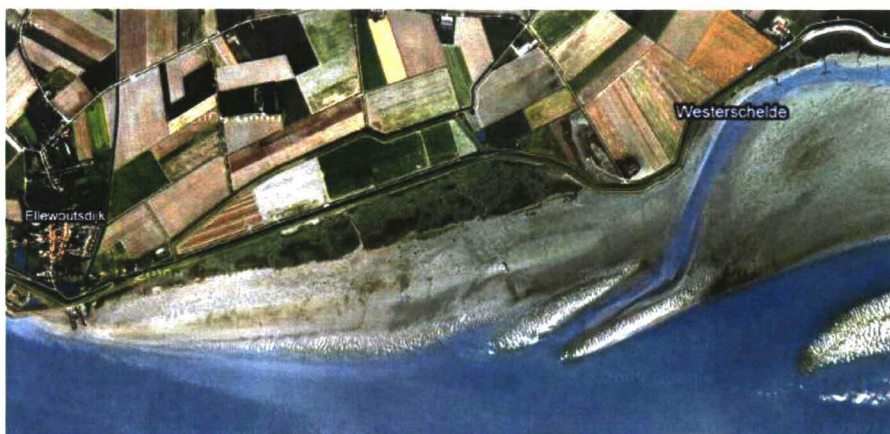
Figuur 1.2: Luchtfoto van het dijktraject Everinge-, Van Hattum-, Ellewoutsdijkpolder + deel aansluitend Baarland (bron: google.earth.nl).
