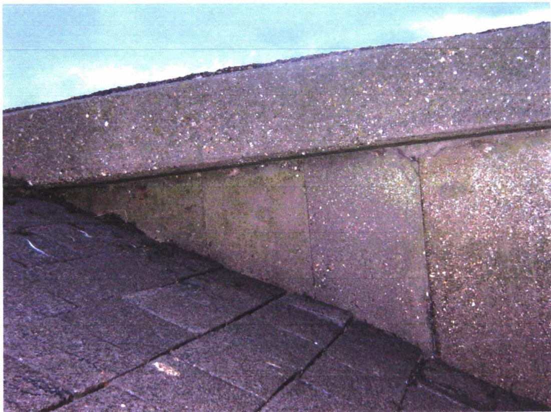
Foto 3: Detail aansluiting loswal op dijk met betonnen damwand
