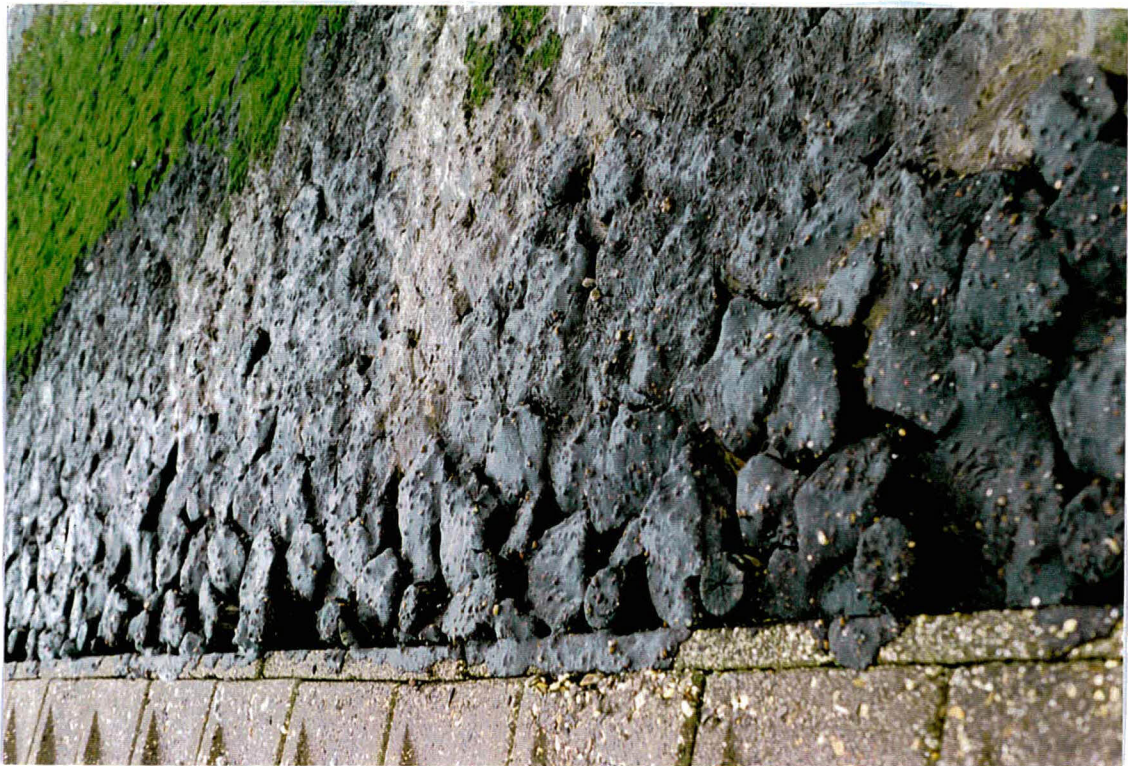
Foto 2 Detail van de ingieting bij de overgang tussen basalt en Harinmanblokken.
