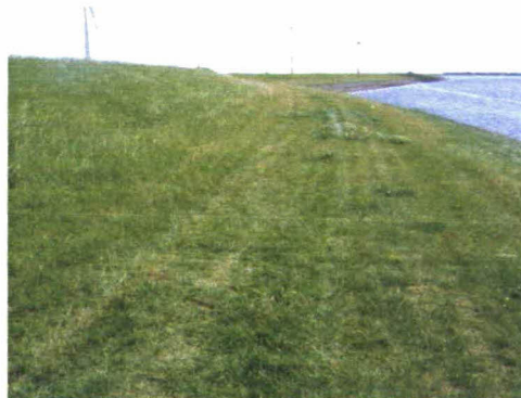
Afbeelding 2: Buitentalud dijk langs Willempolder.
