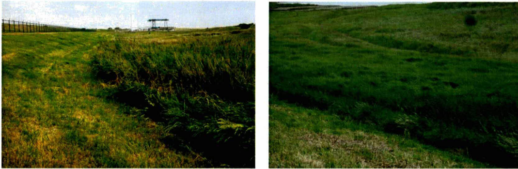
Fig. 4.1 Strook met riet en grassen op en voor de waterbouwkundige teen van de dijk
