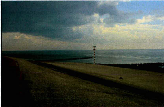
Foto 2.1 De asfalt beklede dijk
