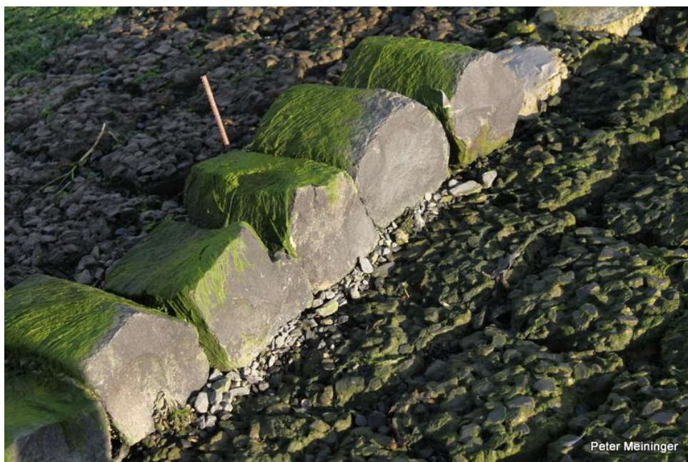
Dijktraject Suzannapolder. Getransplanteerd basalt met groefwier. Te verwijderen steenslag!
