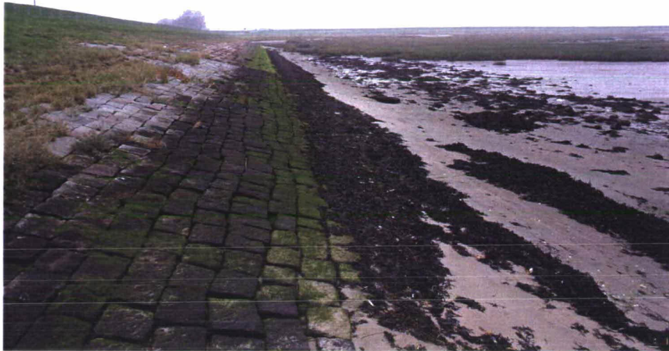
Figuur 6. Glooping van de dijk ter hoogte van deelgebied 7 Schorerpolder.
