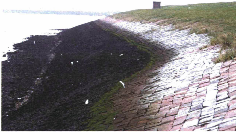
Figuur 5. Gooiing van de binnenzijde van de havendam ter hoogte van deelgebied 5.
