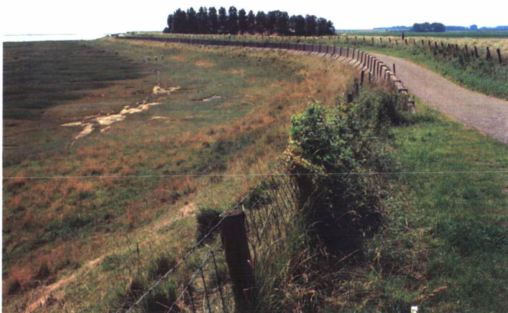
Foto 2.1 De weg op de oude kruin van de dijk met daarlangs een muraltmuur.
