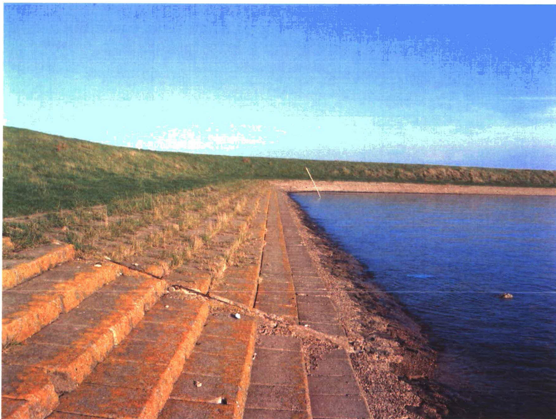
Foto 1.2 Huidige dijkbekleding in deelgebied 5.
