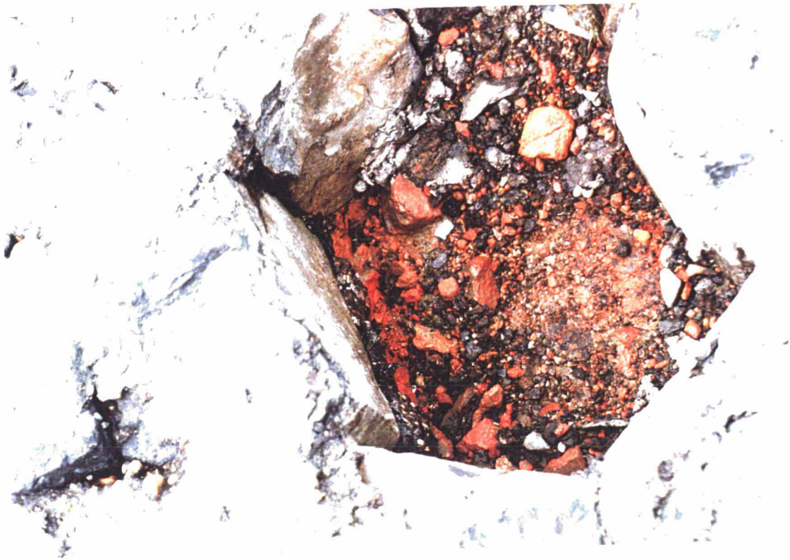
Foto 19 Puinfilter onder de ingegoten basalt.
