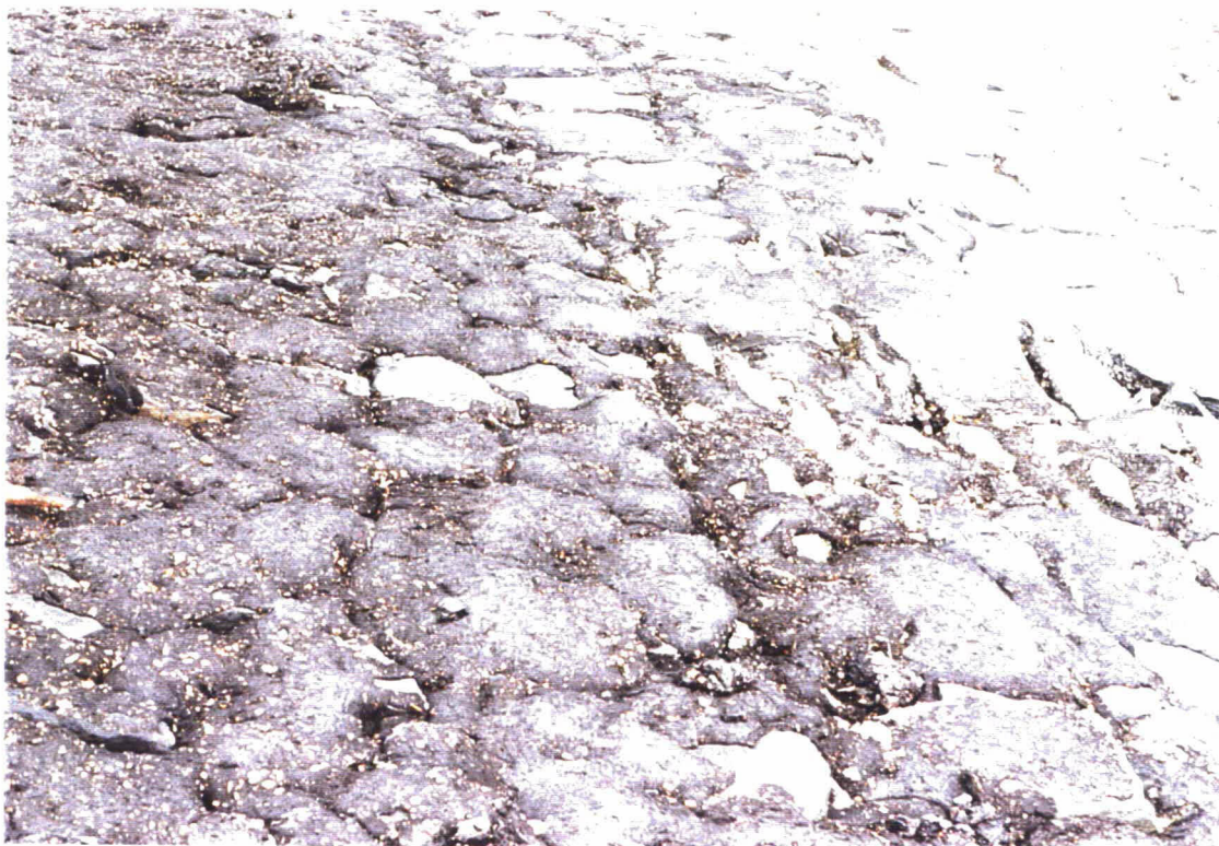
Foto 4 Bij de overgang van basalt naar Doornikse blokken is de penetratie tot over de Doornikse steen doorgelopen.
