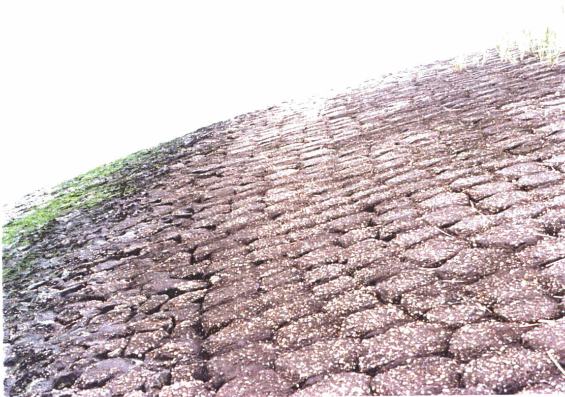
Foto 18 Bekleding 39701, ingegoten basalton, ligt in een bocht bij km 39,85.
