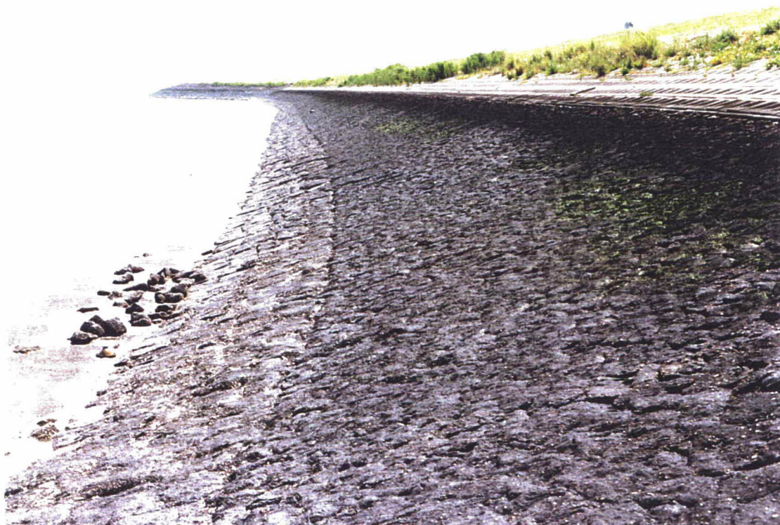
Foto 14 Overzichtsfoto van bekledingsvak 39301. Op de ondertafel ligt Doornikse steen. De asfaltpenetratie is hier voor een deel overheen gelopen.
