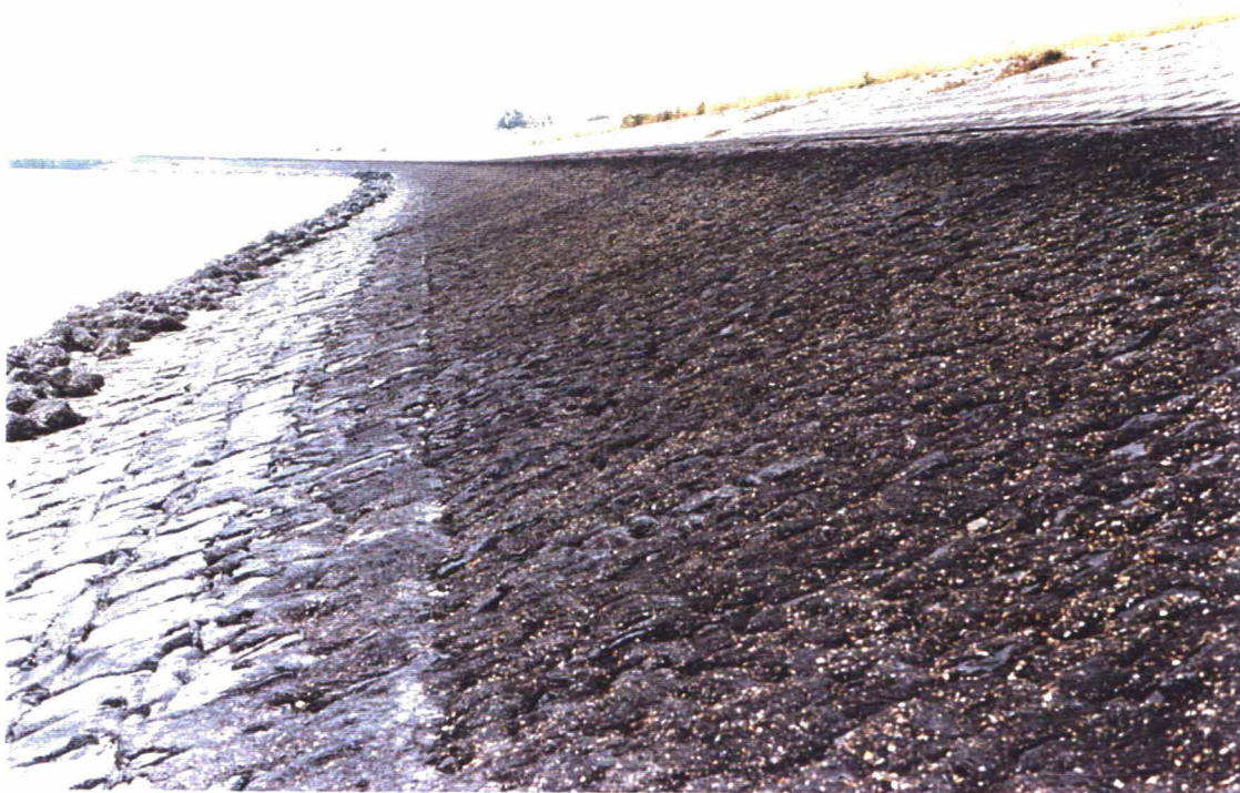
Foto 6 Overzicht van bekledingsvak 38103 bij km 38,35 in zuidelijke richting.
