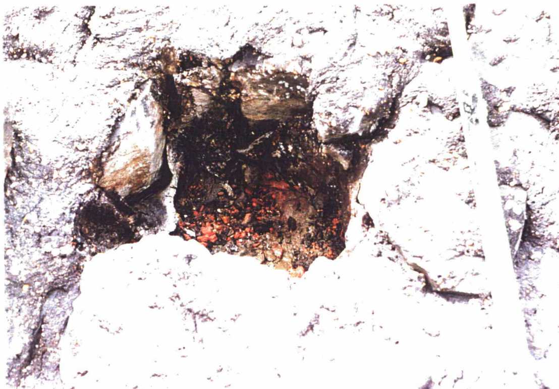
Foto 24 Gat hoog op het talud bij km 39,95. Hier liggen geen slakken maar puin. Te zien is dat de penetratie goed tussen de spleten is doorgedrongen.
