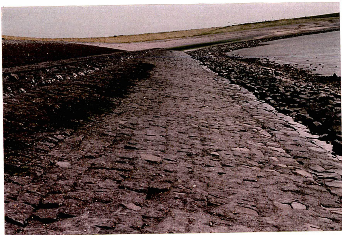
Foto 4 Gepenetreerde granietblokken
