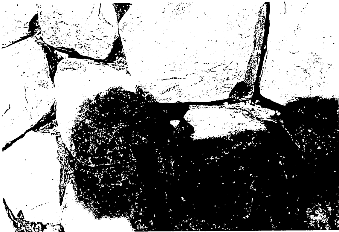
Foto 3 Oostelijke locatie: holte onder het blok
