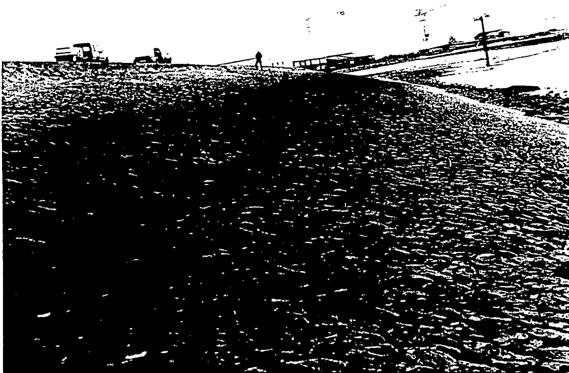
Foto 4: Oostelijke locatie: verzakking over grotere oppervlakte
