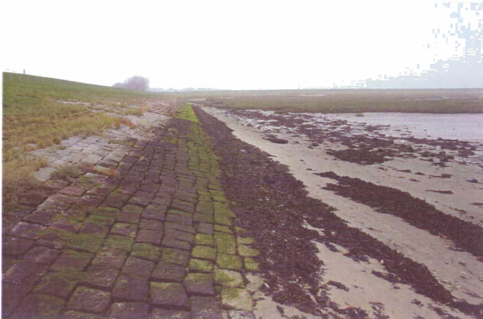
Figuur 6 Glooiing van de dijk ter hoogte van deelgebied 7 Schorerpolder.
