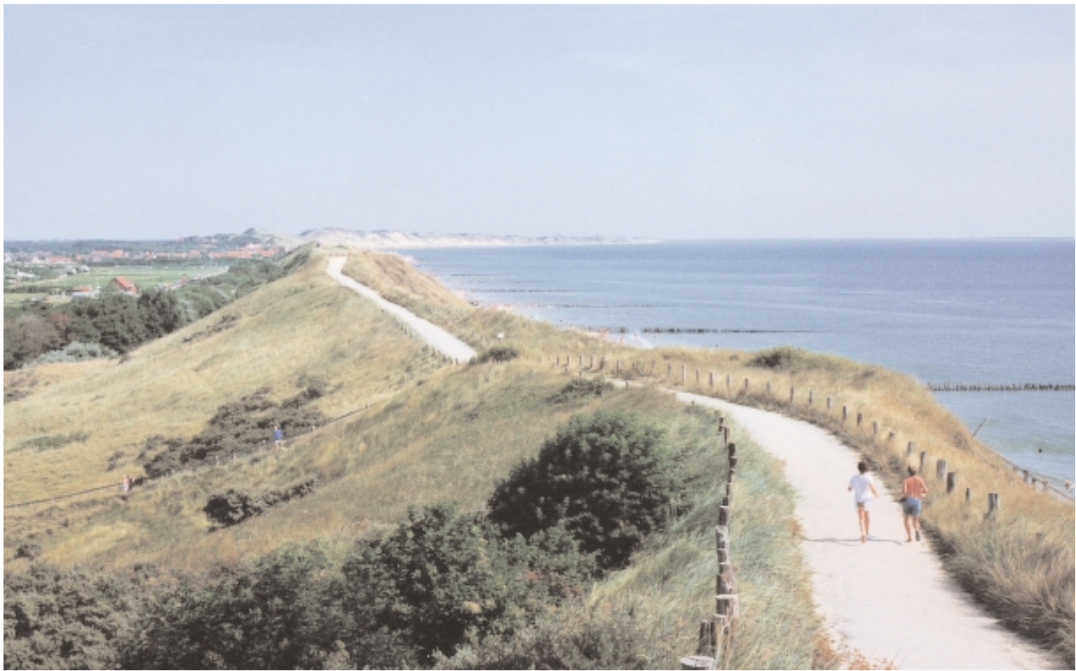
Kust bij Westkappelle, 1994. Achter dijken en smalle duinen moet ruimte worden gereserveerd voor het verbreden van de waterkering in de toekomst.
